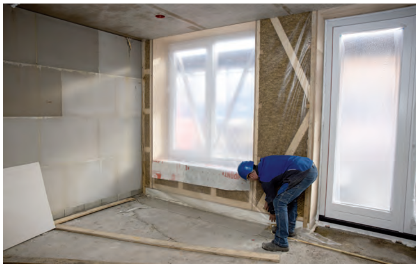
Woning met prefab stropanelen, afgetimmerd links en rechts van de pui.
