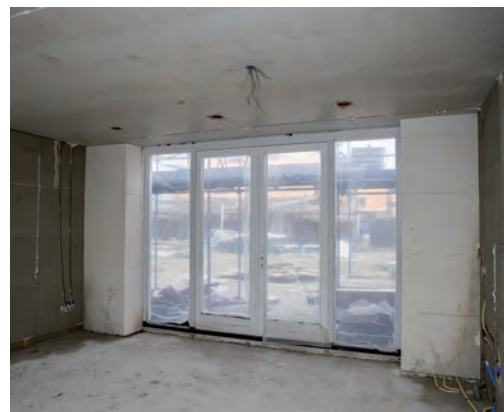
Woning met prefab stropanelen, afgetimmerd links en rechts van de pui.
